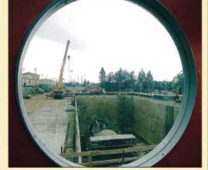
Uno dei cantieri della metropolitana leggera in via di realizzazione
